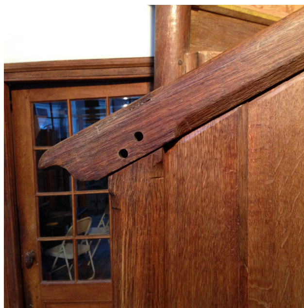
19. Trapphek met gebiljoeneerde trappaal en leuning (na kleuren van het reeds eerder vernieuwde hout).
