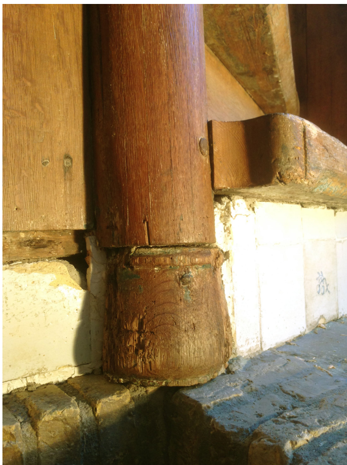
31. Spil met gedraaid basement. In de spil is voor de positie van elke trede een kraslijn aangebracht.
