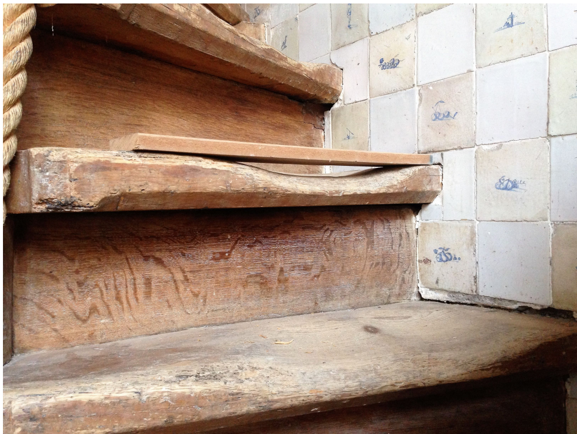
25. De voorste centimeters van de treden zijn het sterkst afgesleten.
