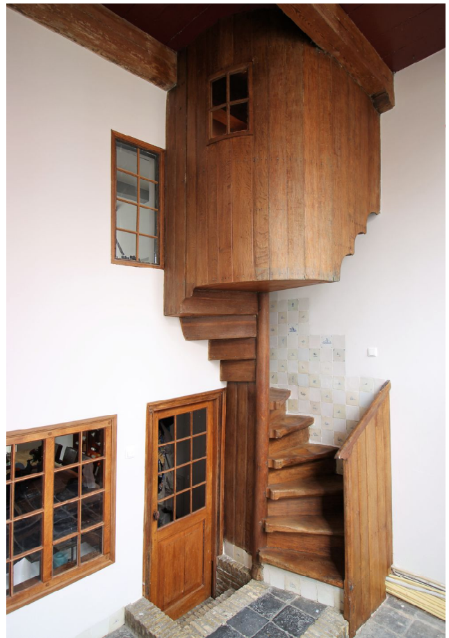
60. Na restauratie: door herstel van de afwerking en kleur vormt het hout van de spiltrap weer één geheel.
