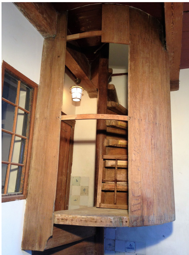
18. Voormalige deuropening in de omkokering. Aan de afgebroken nagels in het bordes is te zien dat hier in de eerste opzet een gesloten betimmering zat.
