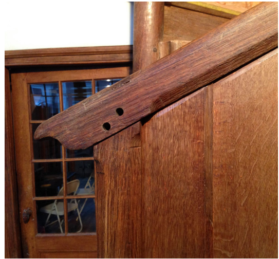
54. Traphek na reinigen en opnieuw kleuren.
