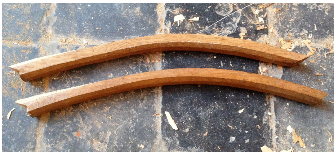
49. De rond uitgezaagde regels waarop de beschieting is aangebracht. De ronding van deze in 1973 vervangen regels is iets aangepast om beter aan te sluiten op de ronding van het bordes. Links zijn de lipverbindingen van de bevestiging met de stijl te zien.
