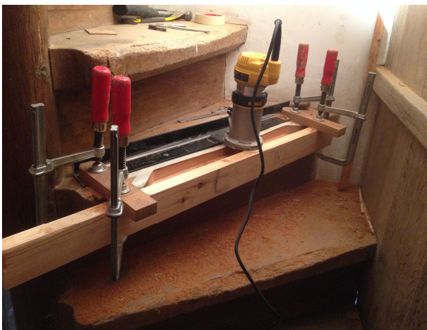
41. Recht uittrezen van de zaagsneden langs een geleider zorgt voor dunne lijmnaden met het nieuwe hout.
