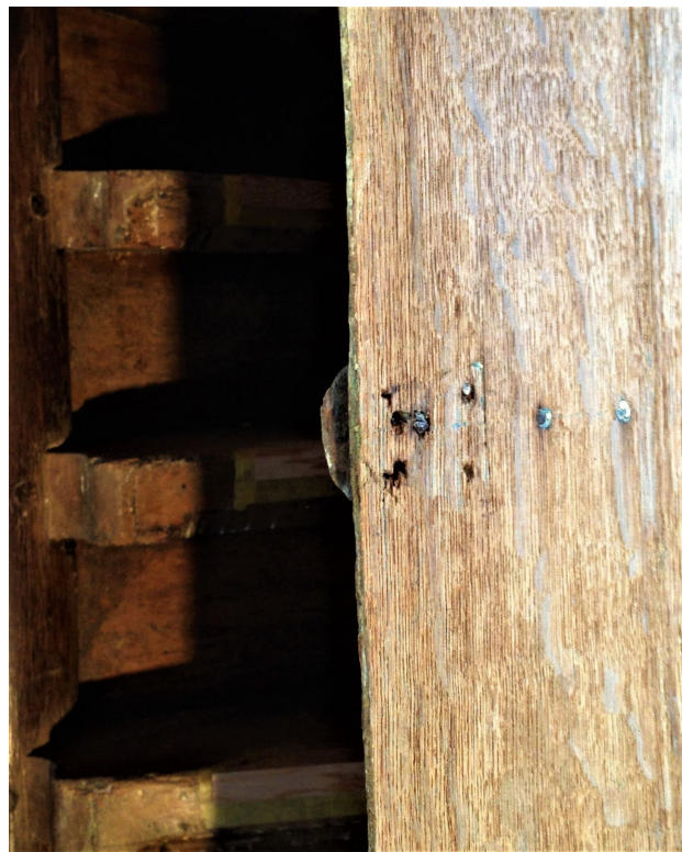
17. Rechterzijde van de opening met de afdruk van een vlinderschanier.
