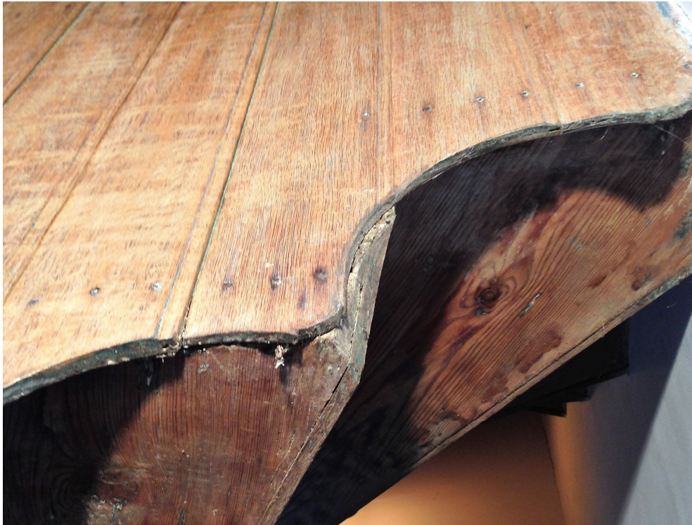
13. Het gat in het stootbord is opgevuld en voorzien van een vloeiende overgang.
