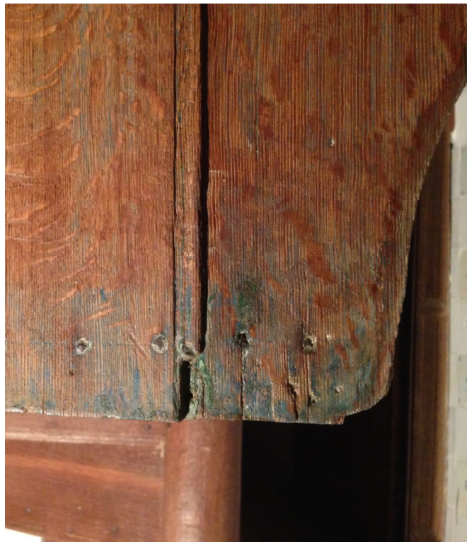
36. Langs de onderzijde van het bordes loopt een band waar de verf minder grondig verwijderd is.
