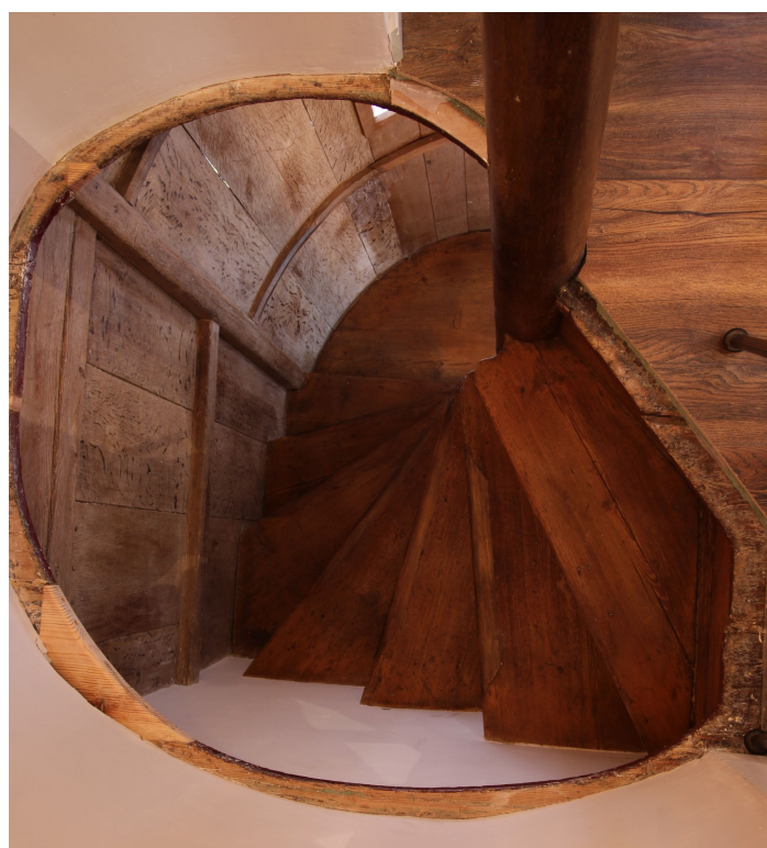
7. Het kleine, rond uitgezaagde trapgat in de vloer van de eerste verdieping van nr.58.
