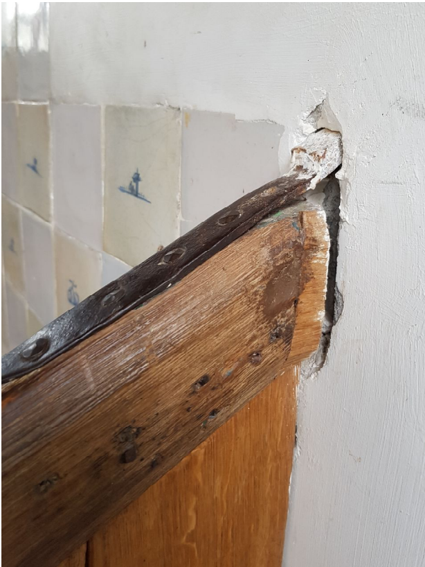
55. De verbinding tussen de te korte leuning en de muur met een muuranker.
