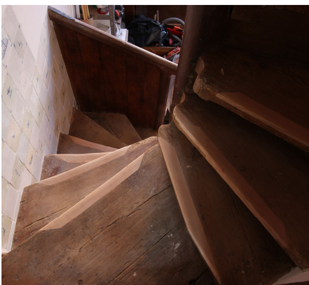
43. Door alleen ter plaatse van het loopvlak van de treden in te boeten is maximaal oorspronkelijk materiaal behouden gebleven.
