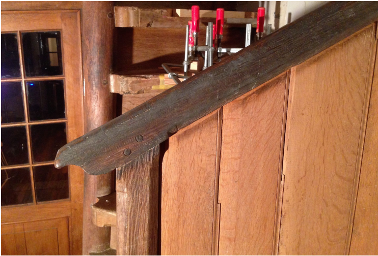
53. Traphek vóór herstel, zwart geworden door huidvet.
