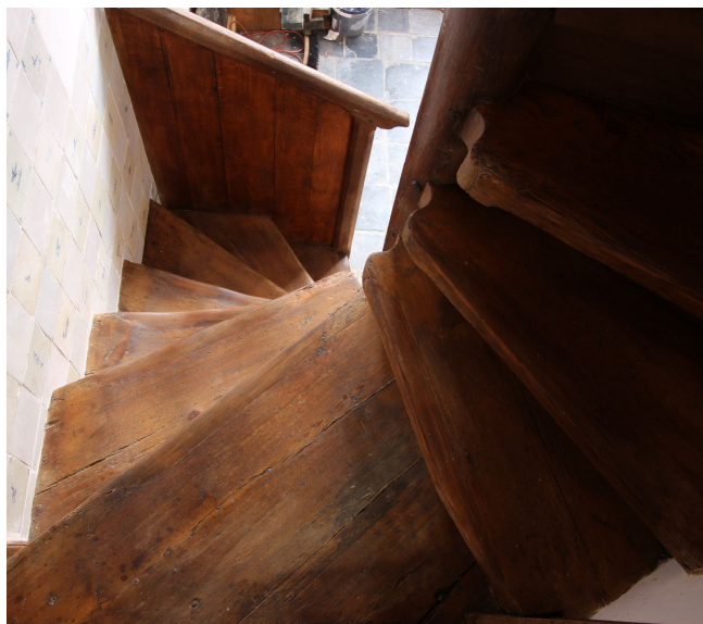
44. Na het beitsen is met zwarte en rode was het bonte kleurenpalet van de treden doorgezet.
