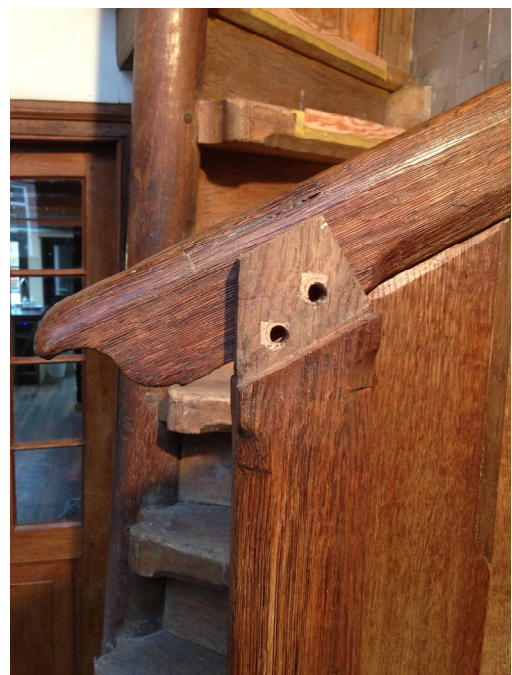
52. De te ruim geworden gaten van de toognagels zijn eerst opgevuld en daarna opnieuw uitgeboord.
