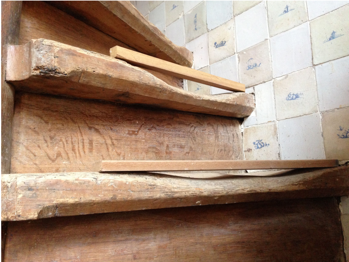
39. Na aantasting door houtworm is vooral het voorste gedeelte van de treden weggesleten.
