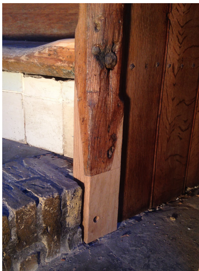
58. De verlengde trappaal heeft onderaan nu een extra verbindingpunt voor meer stabiliteit.
