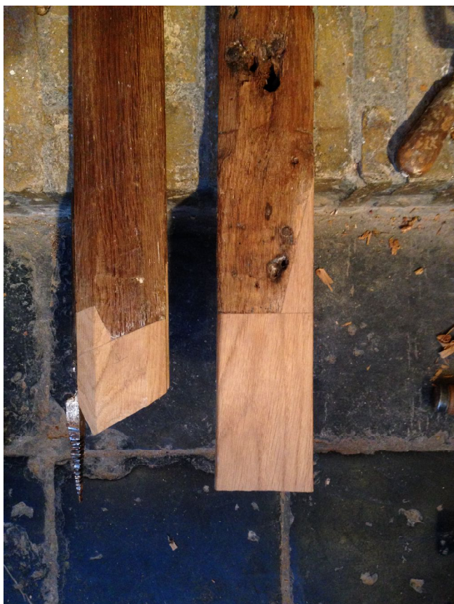
57. Verlengde leuning en trappaal.
