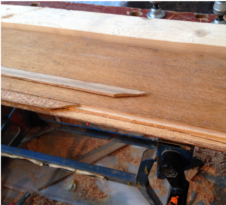
51. Uitgebroken profielen worden aangeheeld.
