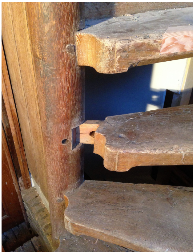
23 en 24. De pen-en-gatverbinding van de trede in de spil.
