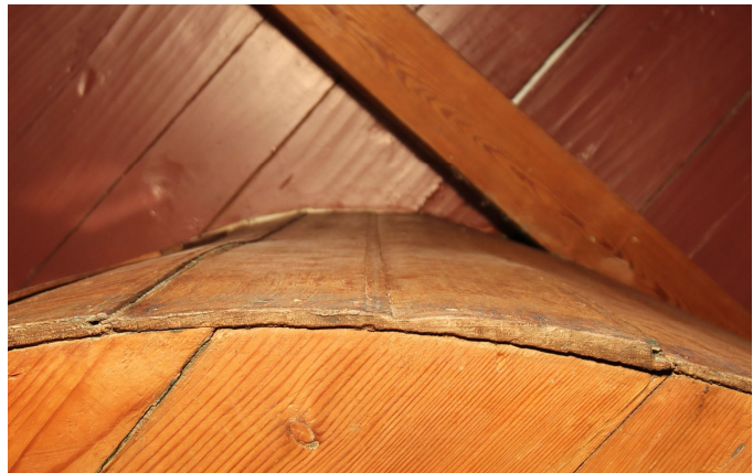
9 en 10. Beschieting van kwartiers gezaagd wagenschot. Het profiel in het midden wekt de schijn van smallere delen.
