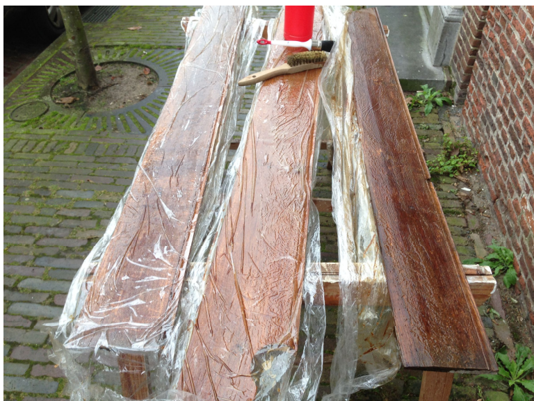
47. Met ammonia wordt in één handeling de waslaag verwijderd en het eiken donkerder gekleurd. Folie voorkomt te snelle verdamping van de ammonia.
