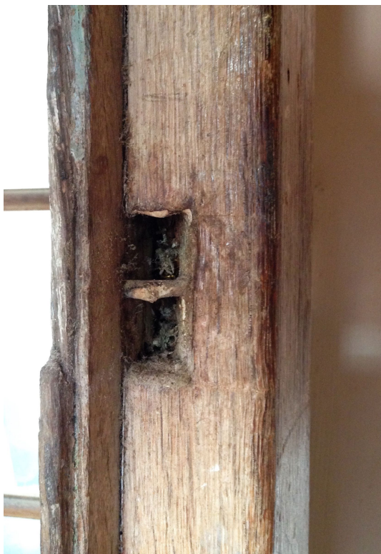
16. Linkerzijde van de opening met uitgebroken groef en de oorspronkelijke verbinding van de gebogen regel.
