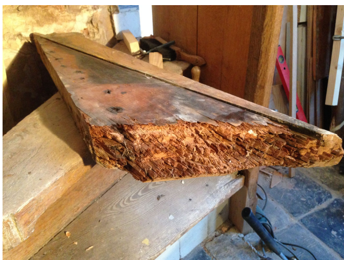
45. De door houtrot aangetaste kop van trede 3.
