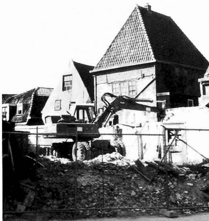
De sloop van het pand aan het Kerkplein in 1981
