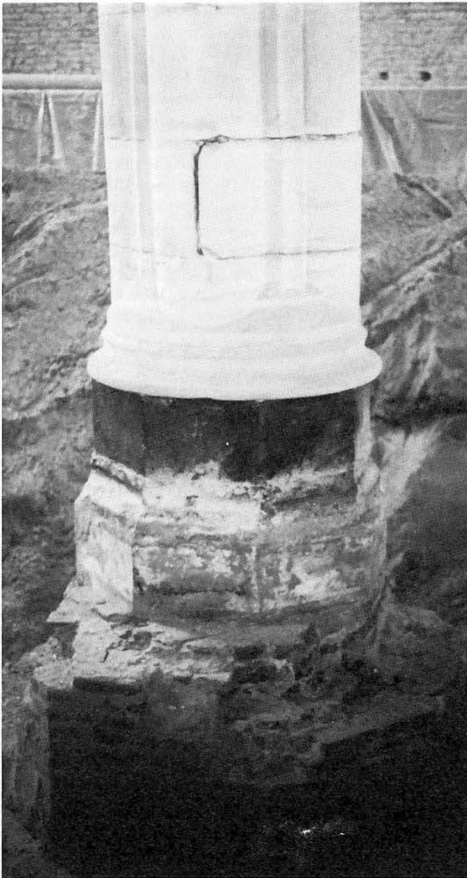
Restauratie van de fundering van de pilaren in de Noorderkerk uit 1986
