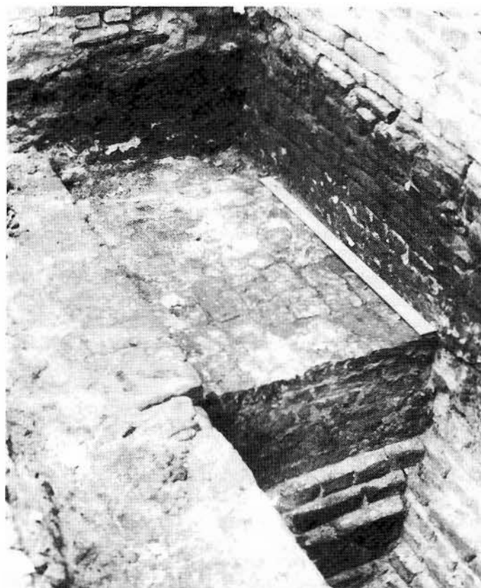
Steunbeer van de oostelijke zijmuur van de Oosterkerk, met daarvoor het fundament van een oude steunbeer, behorend bij de bouw-fase van 1483
