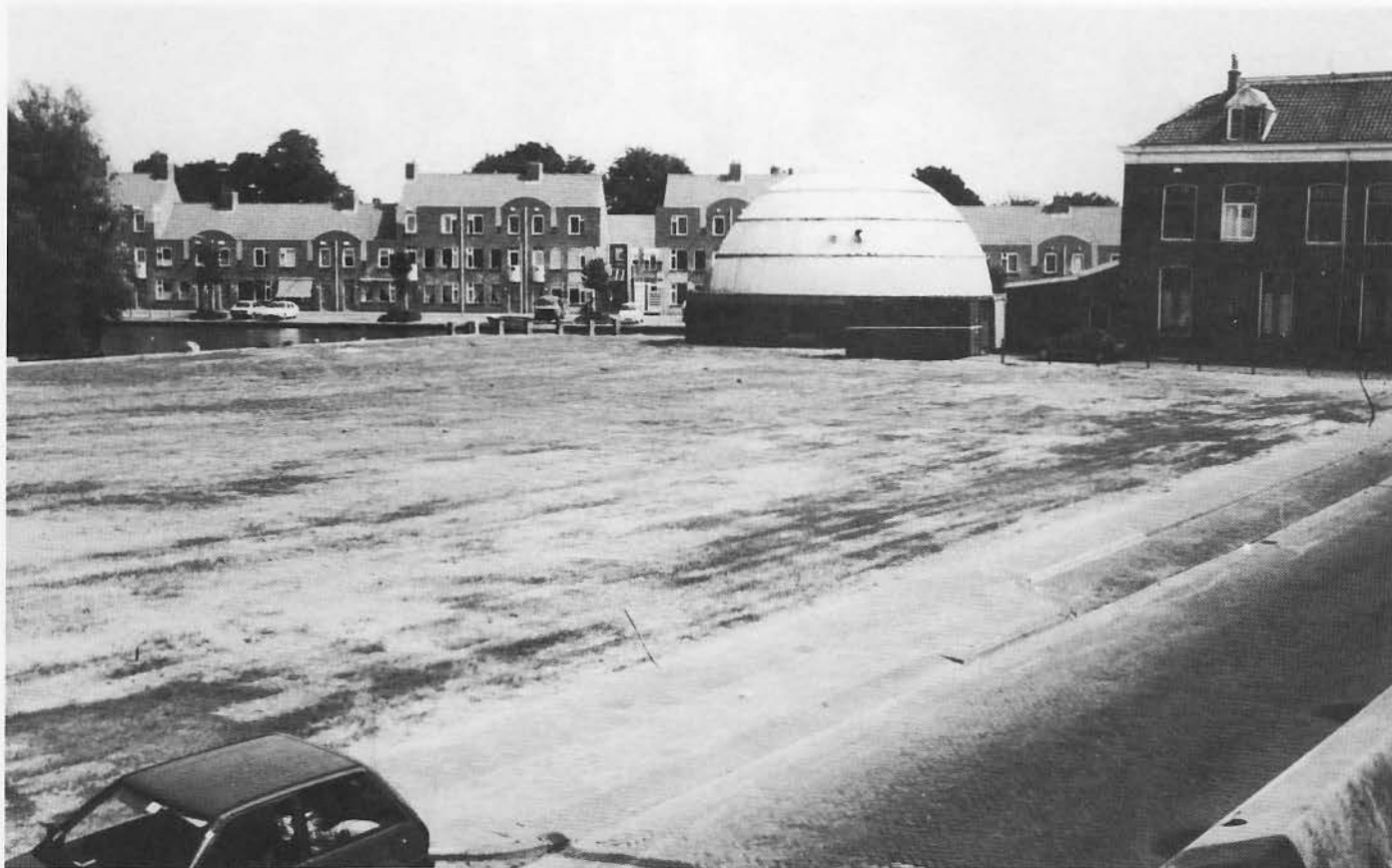
Braakliggend terrein, nog met koepel, 1989
