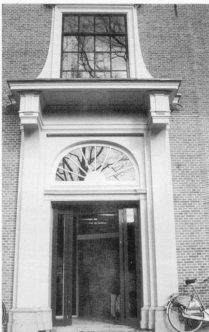
Een detailopname van het bankgebouw: de nieuwe monumentale entree van de hand van schrijnwerker Ben Hagenaars, een waar stuk ambachtelijk vakmanschap.
