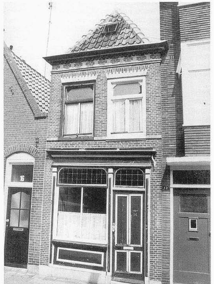
Eén van de huizen die op de MIP-lijst staat is pand nr. 14 in de Achterstraat.
