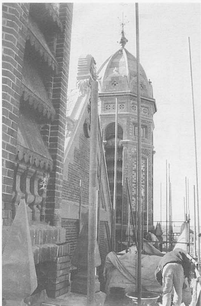
Hier is de restauratie van de Koepelkerk in volle gang. De torentjes aan de voorzijde bleken er bouwkundig erger aan toe dan gedacht.
