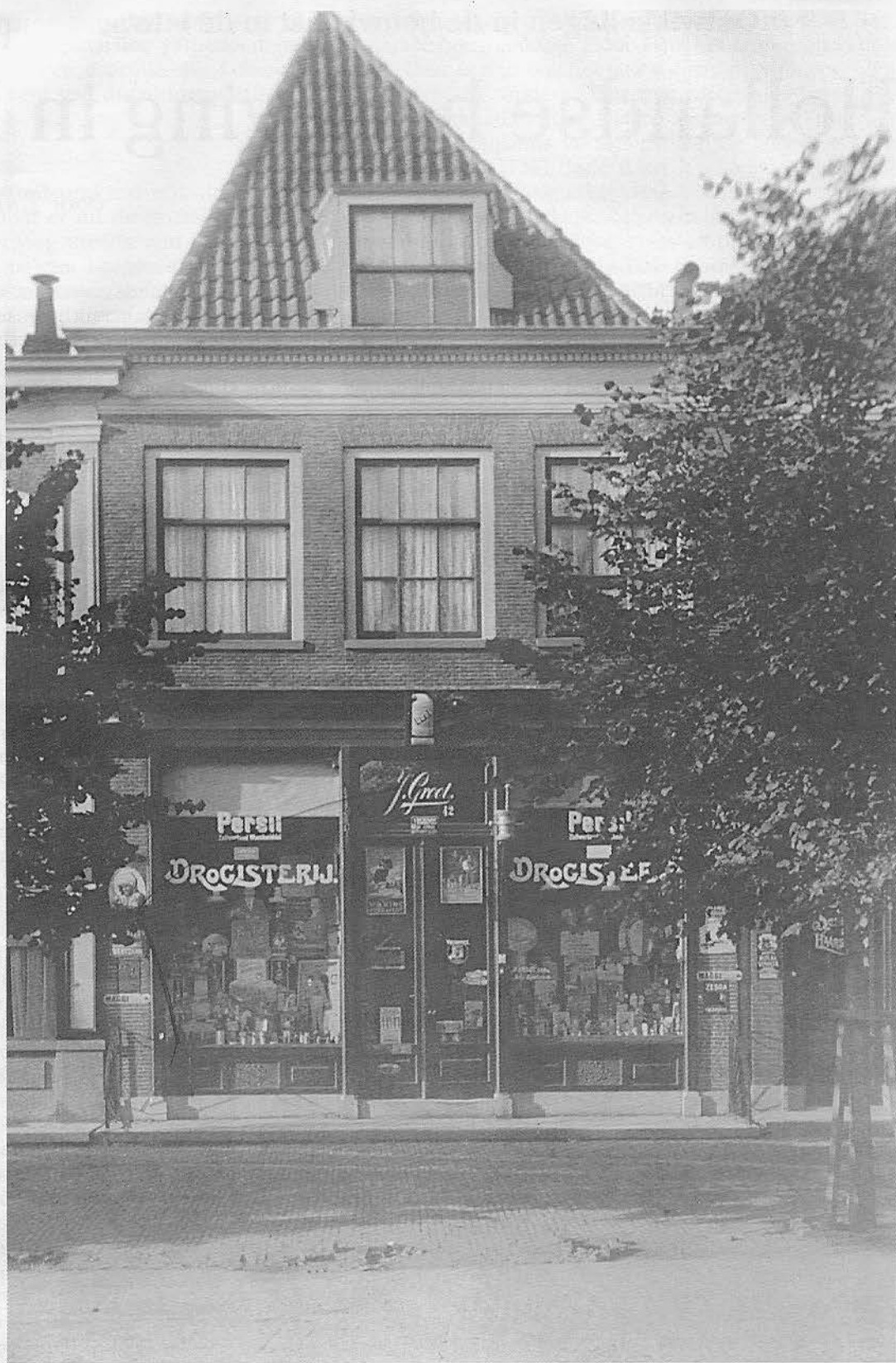
Gedempte Turfhaven 42 in Het aanzicht van de jaren dertig.
