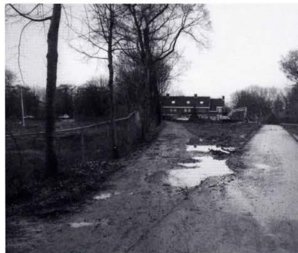
Nieuwe en oude loop Binnenluiendijk naast elkaar.
