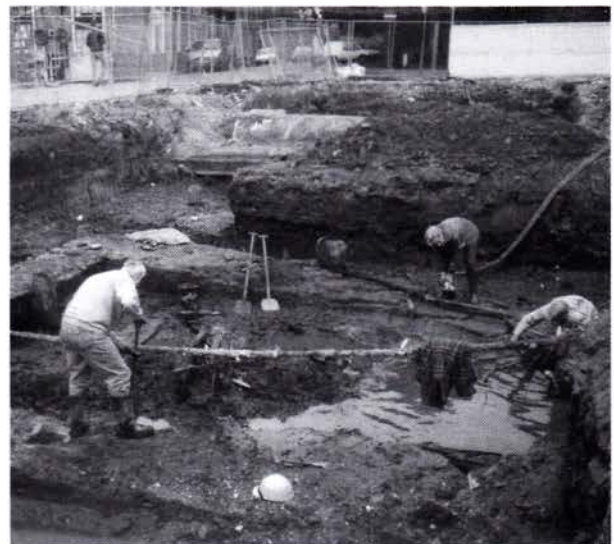
Tegenover hoek jeudje, Achter de Vest, Pakhuisstraat. Het fundament van de St. Geertentoren wordt langzaam blootgelegd
