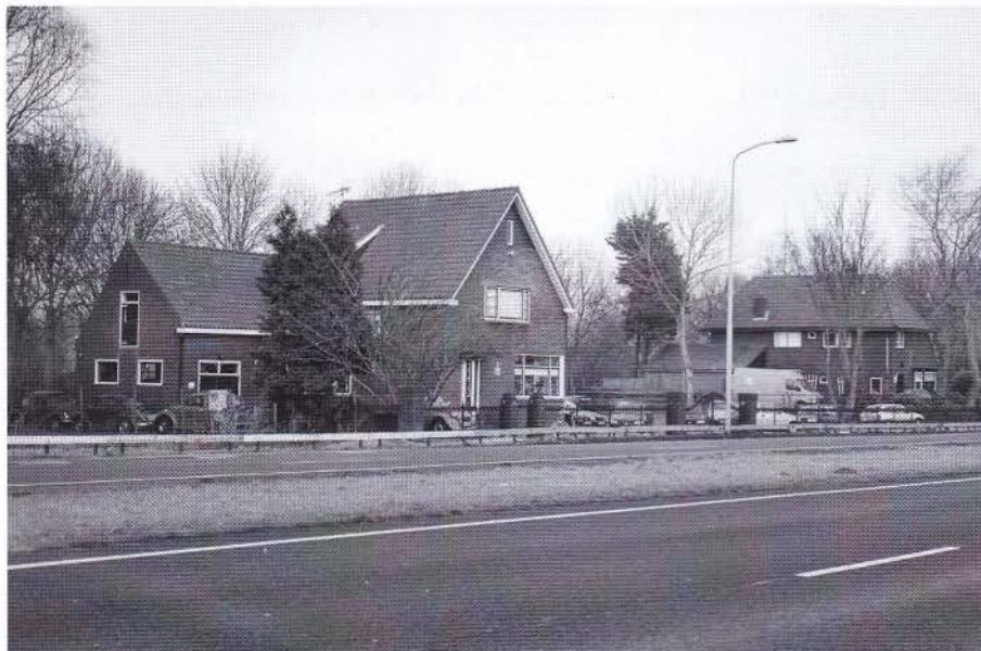
Blauwe Berg, overzichtsfoto met de twee woningen langs de Provinciale Weg. Zie pag. 10
