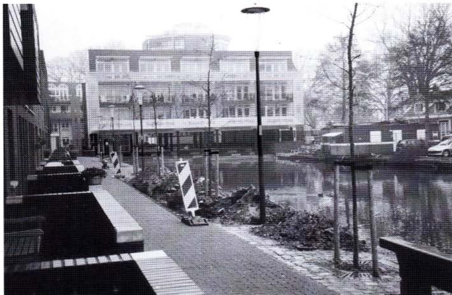
Graafwerkzaamheden op de zuidwestoever van de Vollerswaal
