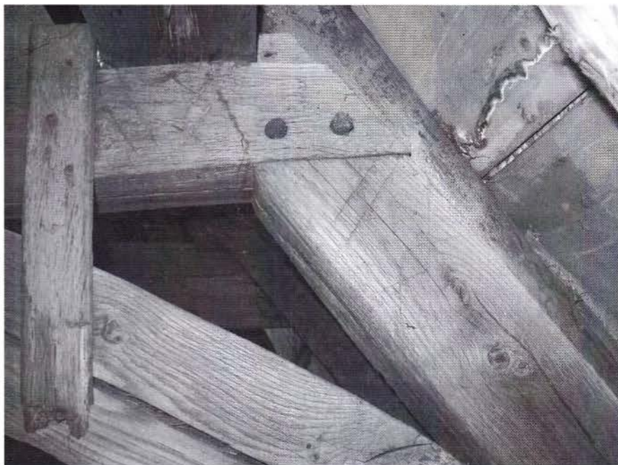
afb. 7: Houten dakconstructie met telmerken van voor 1550.
