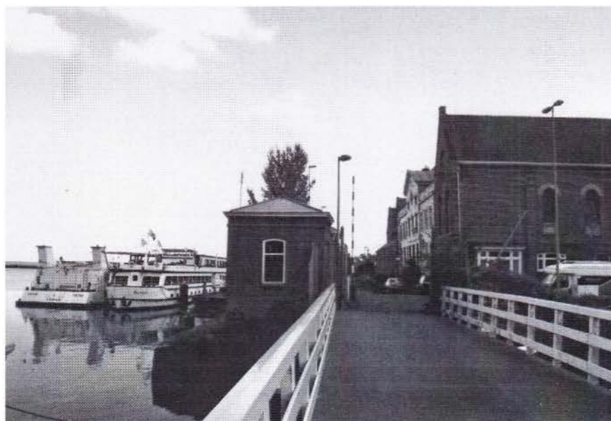
Monumentenvergunning aangevraagd voor Oostereiland en plaatsen van steigers.
