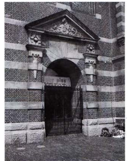
Kerkplein, hekwerk in doorgang geplaatst.
