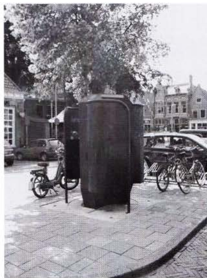
Kerkplein, openbaar toilet aansluiting.
