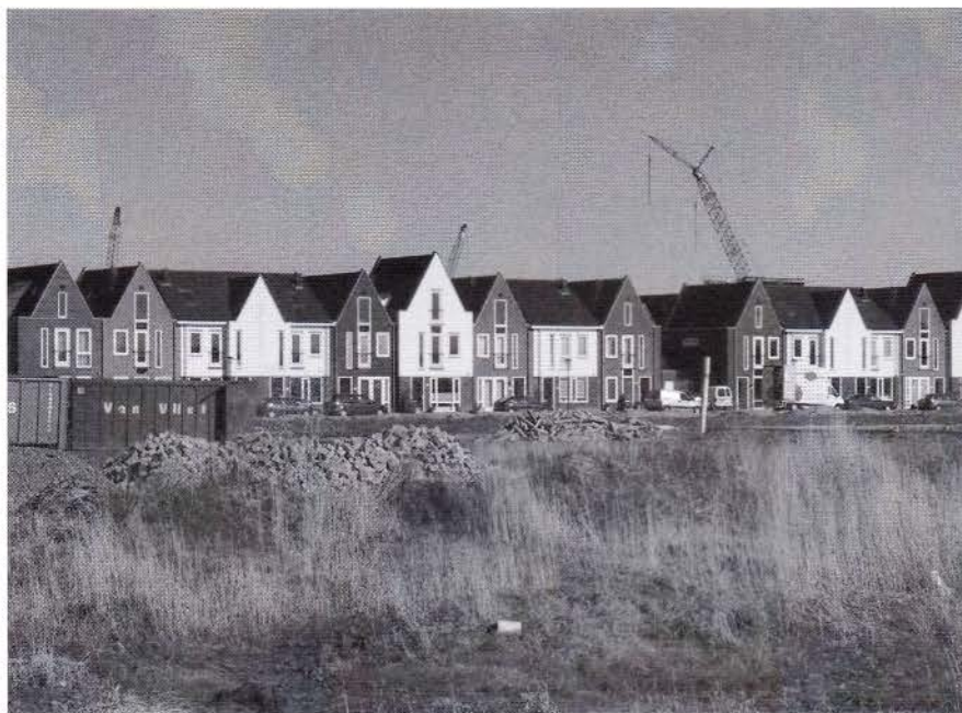
Bangert-Oosterpolder: wijk in aanbouw.
