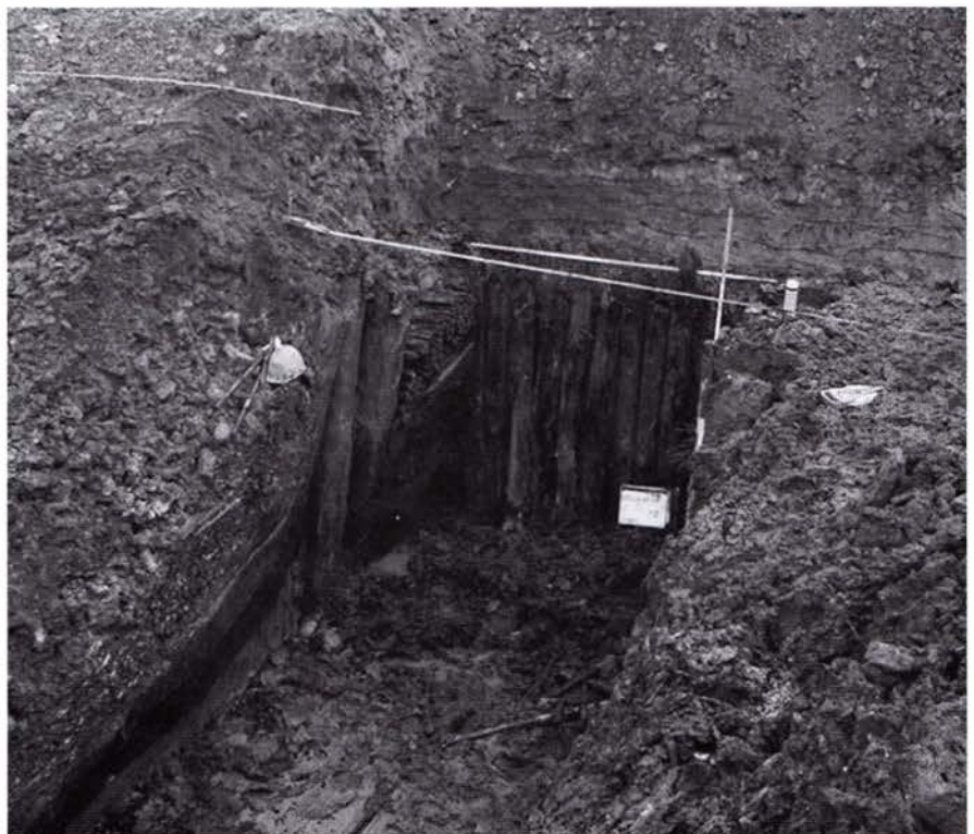
Afb. 6: Aanzicht van paalversterking met op de achtergrond de puinophogingen van de dijk.
