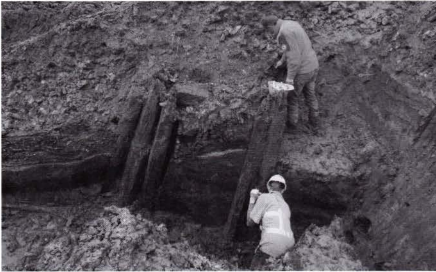
Afb. 5: Rechts structuur 1 (twee rijen palen) en links structuur 1 (drie rijen palen). De ruimte tussen beide is opgevuld met sparren.
