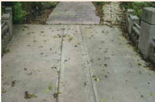
Brug met rails voor lorry
