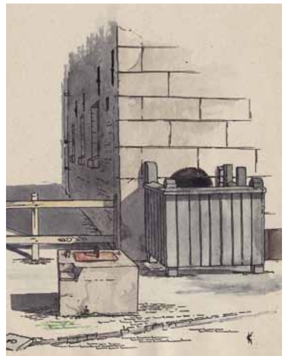
Het veel gefreundeerde 'piesbakkie' op de hoek van de cellen in de doorgang in de oostvleugel
