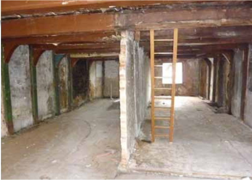
Opmnames tijdens de restauratiewerkzaamheden, met o.a. de zeventiende eeuwse muurstijlen en korbelen. Goed te zien is dat Breed 22-24 oorspronkelijk een dubbel-pand is geweest
