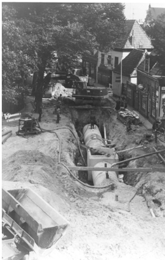
De vervanging van het riool op het Kerkplein in 1978, kijkend vanuit de Boterhal
