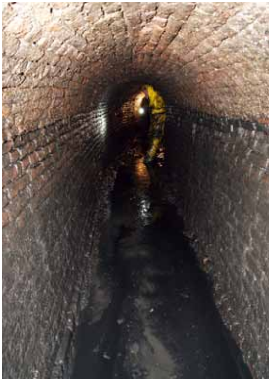
De rioolgang onder de Boterhal, januari 2015
