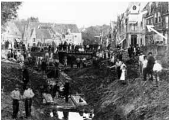
Afb. 9 Demping Turfhaven in volle gang (ca. 1882), gezien richting Hotel De Doelen. Op de bodem wordt een overluisde watergang aangelegd Ramen 37 in het midden van de gevelwand rechts (pijl)
