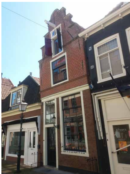
Kruisstraat 15 met hijsbalk
