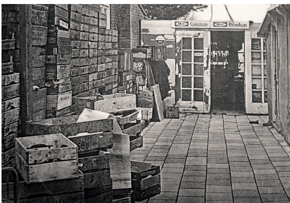
De entree van de in de schuur gebouwde winkel. Circa 1960
